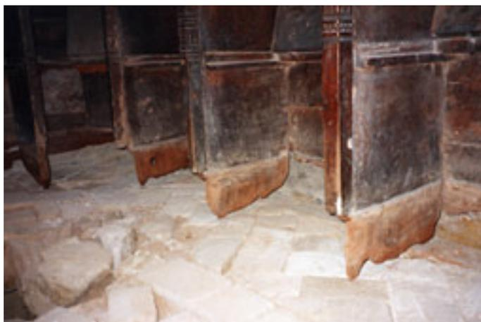
Fig. 17 - Degrado della base dei divisori a contatto con il pavimento e sotto al piano di calpestio, dopo lo smontaggio
