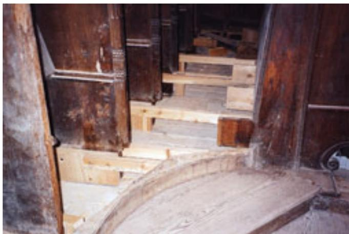
Fig. 18- La nuova struttura in larice con i rinforzi alla base dei divisori e l'isolamento dal pavimento con la lamina di piombo.
